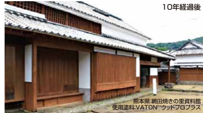
MOKリバブラスト処理 ひび割れも無くほとんど劣化は見られない。 テープで剥離しても着色層はほぼ剥 がれない。
