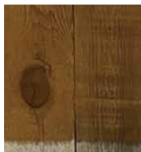
研磨処理 + 浸透型塗料 下地の汚れが透けた仕上がり
